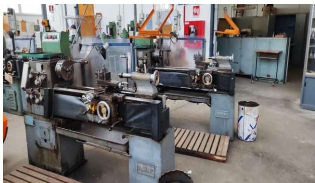
tipologia di torni con protezioni fisse pulsante di arresto e microswitch di protezione
